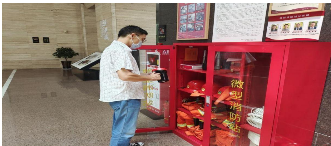
○消防器材检查
